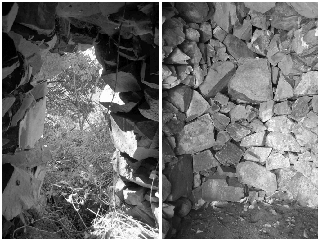
Barraca del Marino. Detall de la porta i paret interior.
